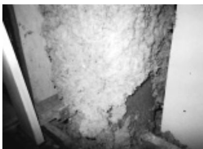
鉄骨に直接吹き付けられていたアスベスト
