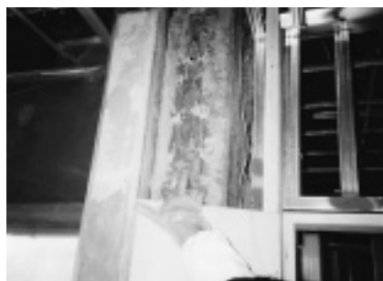
鉄骨に直接吹き付けられていたアスベスト
