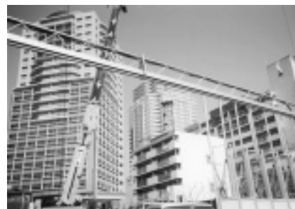
進む高層ビル建築
